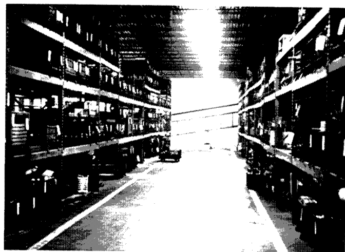
完成部分的储存室
